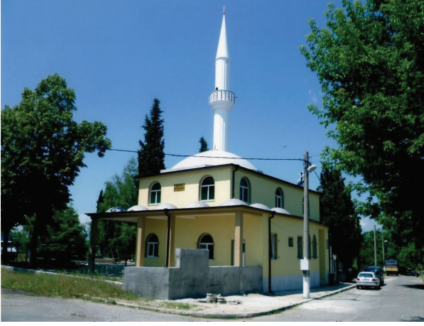
Kırcaali'deki Tuzluk Köyü Kerim Çavuş Camii, 2010
